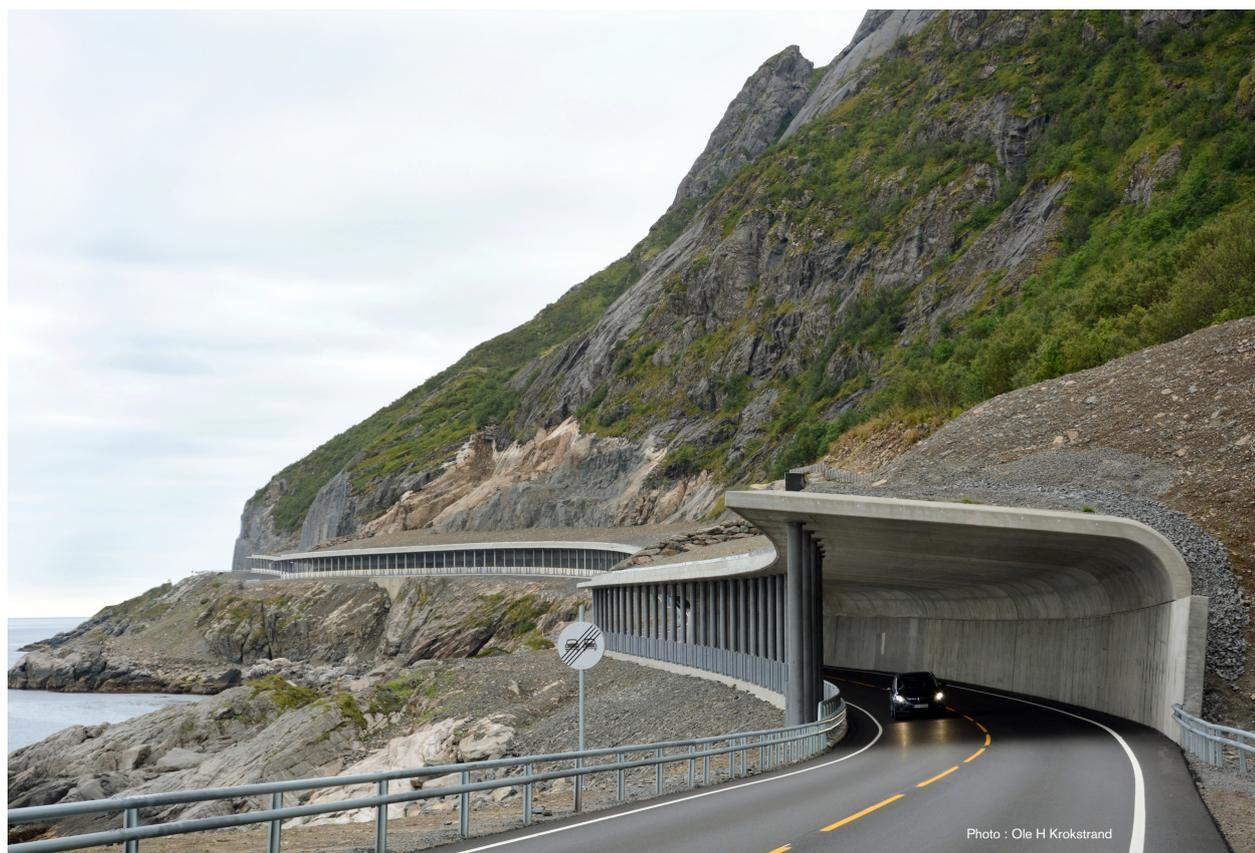
La realizzazione del progetto è stata molto impegnativa ma è riuscita nell'intento di ridurre al minimo l'impatto ambientale, prevedendo ampi spazi aperti nel tunnel e permettendo quindi ad automobilisti e ciclisti di poter ammirare lo spettacolare Vestfjorden e il paesaggio circostante. Lungo tutto il tratto è stato inoltre adottato il principio della rivegetazione
